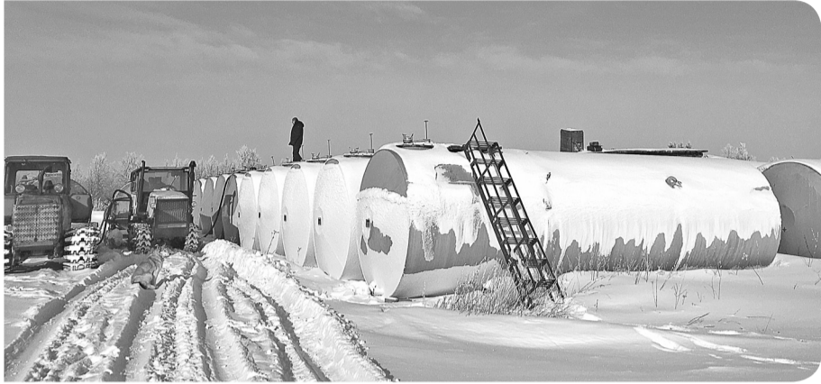
Новый парк хранения ГСМ в Оме из 20 ёмкостей смонтирован в 2017 году
