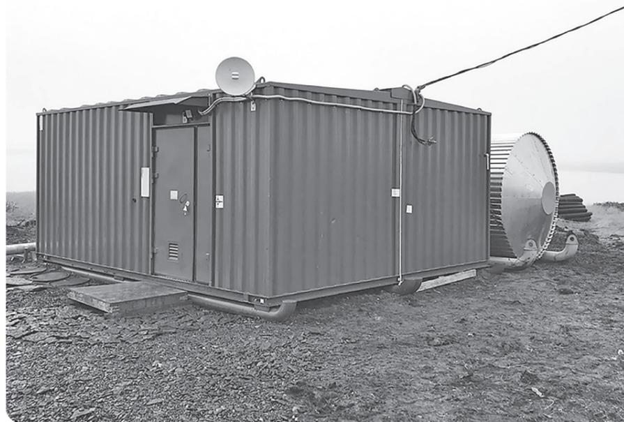
Водоподготовительная станция в Варнеке оснащена опреснительным модулем, так как водозабор осуществляется из морской бухты вблизи населённого пункта.
