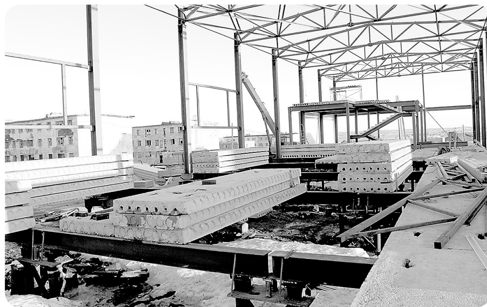
Строительство спорткомплекса в Амдерме продолжается
